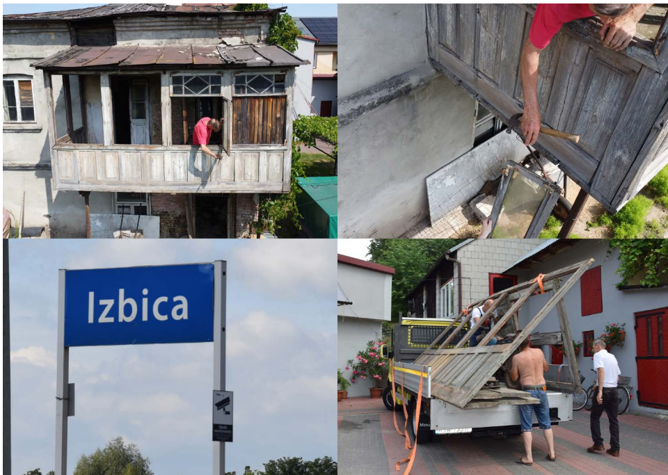
Fot. 5. Proces demontażu kuczki z Izbicy, 2022
